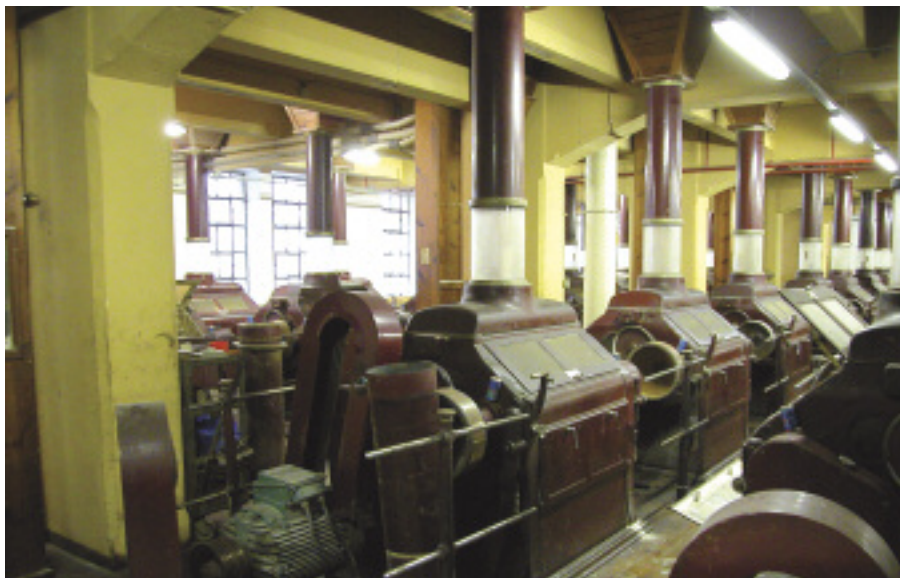
Au 1 er étage du moulin, la salle des broyeurs à cylindres Simon mis en service en 1948.
