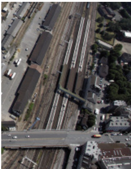
À gauche des rails, des hangars qui remontent aux origines de la gare de marchandises.
