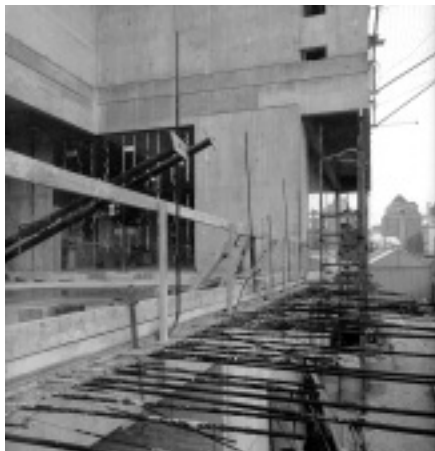
Les fers à béton du centre administratif en cours de construction.
