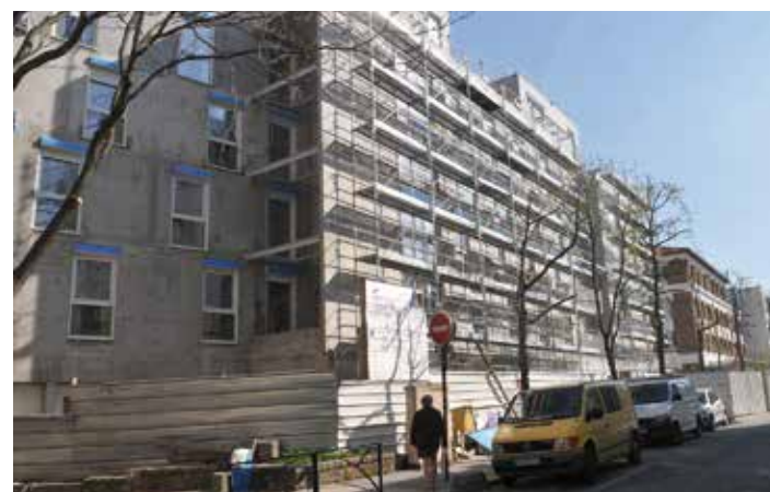
Angle Hoche-Liberté : les vingt-huit logements en accession sociale à la propriété sont sortis de terre.
