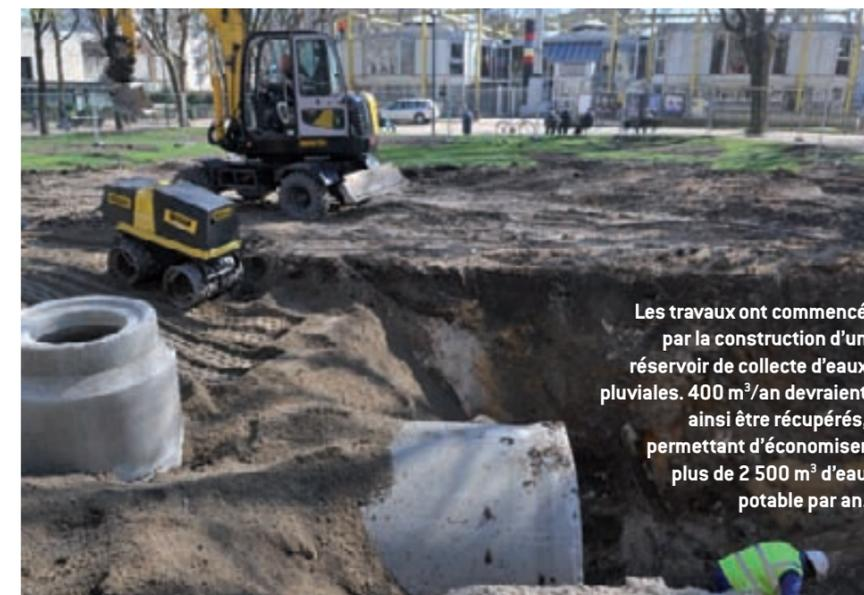
Les travaux ont commencé par la construction d'un réservoir de collecte d'eaux pluviales. 400 m<sup>3</sup>/an devraient ainsi être récupérés, permettant d'économiser plus de 2 500 m<sup>3</sup> d'eau potable par an.
